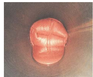
Innenansicht harzgetränkter Liner bei der Reversion
